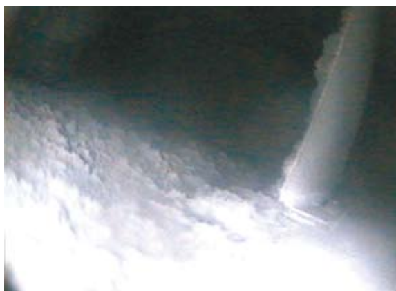
DEPOSITO DI IMPURITA' ALL'INTERNO DELLE CONDOTTE
