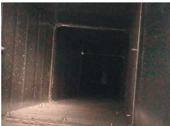
RIVETTI E VITI SPORGENTI ALL'INTERNO DELLA CONDOTTA
