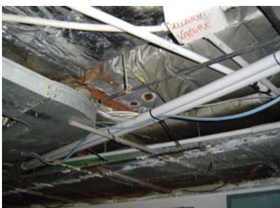
CORROSIONE CONDOTTA IN LAMIERA RILEVATA SOTTO IL MATERASSINO COIBENTE
