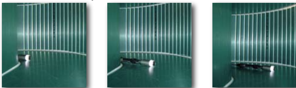
Video ispezione all'interno della condotta ALPactive®
