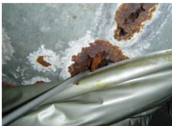
CORROSIONE CONDOTTA IN LAMIERA RILEVATA SOTTO IL MATERASSINO COIBENTE
