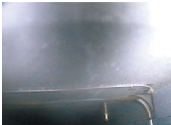
RIVETTI E VITI SPORGENTI ALL'INTERNO DELLA CONDOTTA
