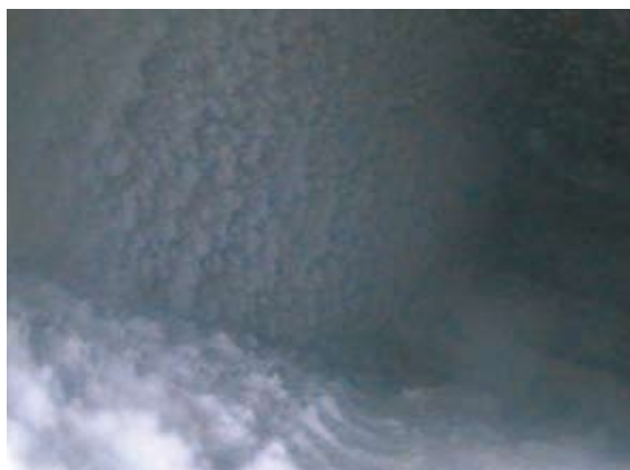
DEPOSITO DI IMPURITA' ALL'INTERNO DELLE CONDOTTE
