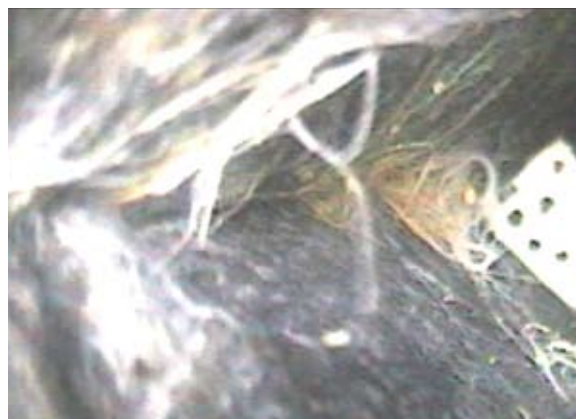
COIBENTAZIONE INTERNA CON RILIEVO DI UN ALVEARE
